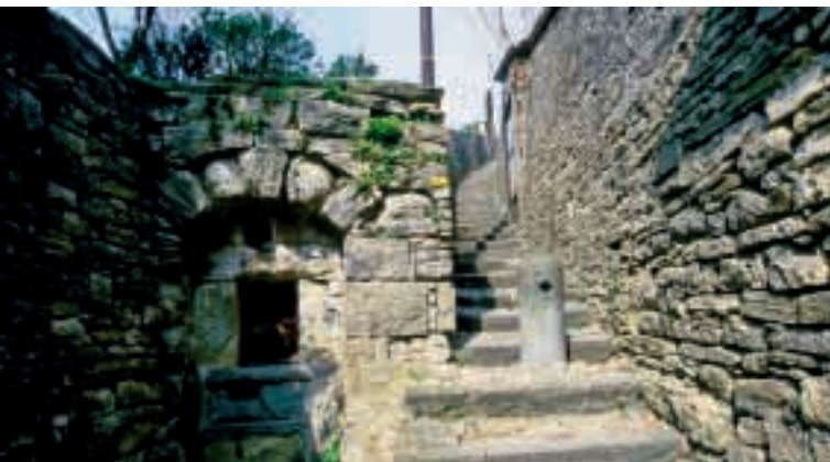
Il seicentesco pozzo dello Scorlazzone.
