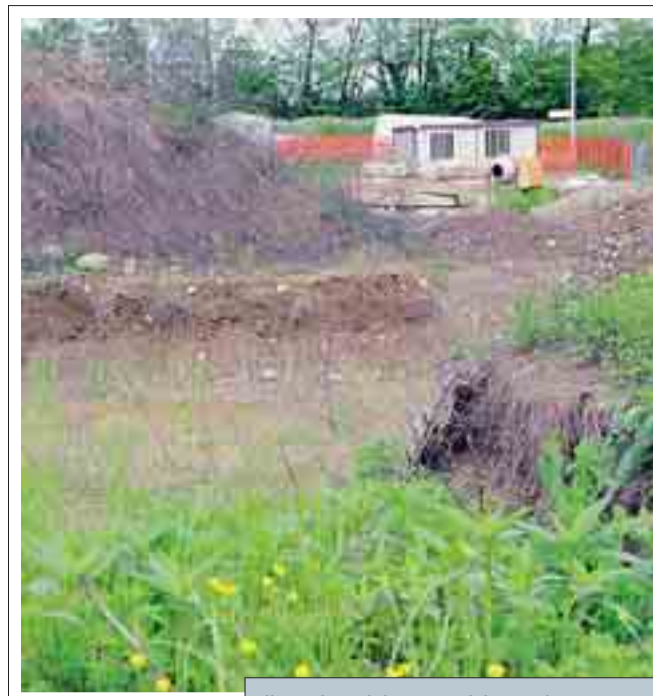
Il cantiere del centro civico andratese
