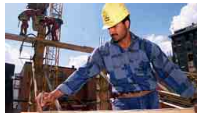
Controlli a tappeto nei cantieri edili della città e della provincia
