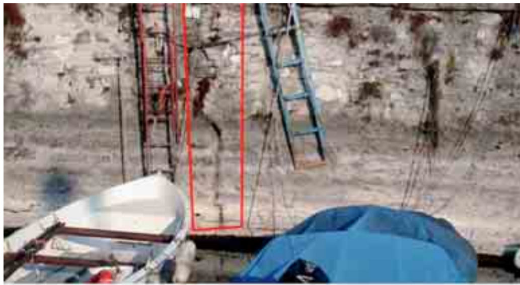
Nel riquadro rosso la crepa sul basamento del vecchio molo di Cernobbio
