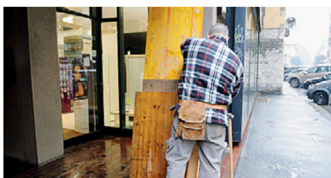
Muratore al lavoro alla profumeria Marrionaud di via Garibaldi
